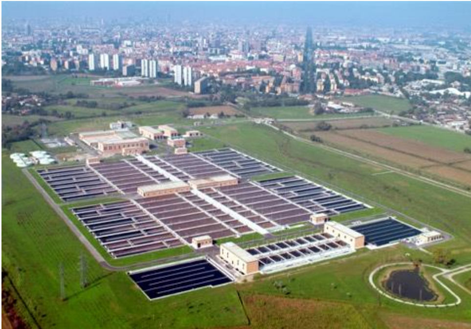
DEPURATORE MILANO NOSEDO
