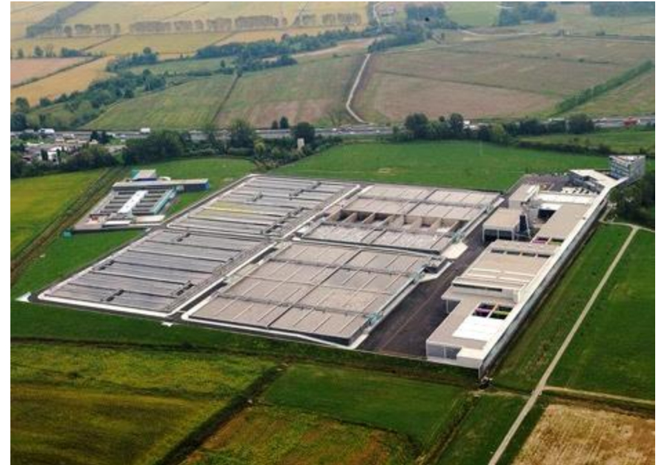
DEPURATORE MILANO SAN ROCCO
