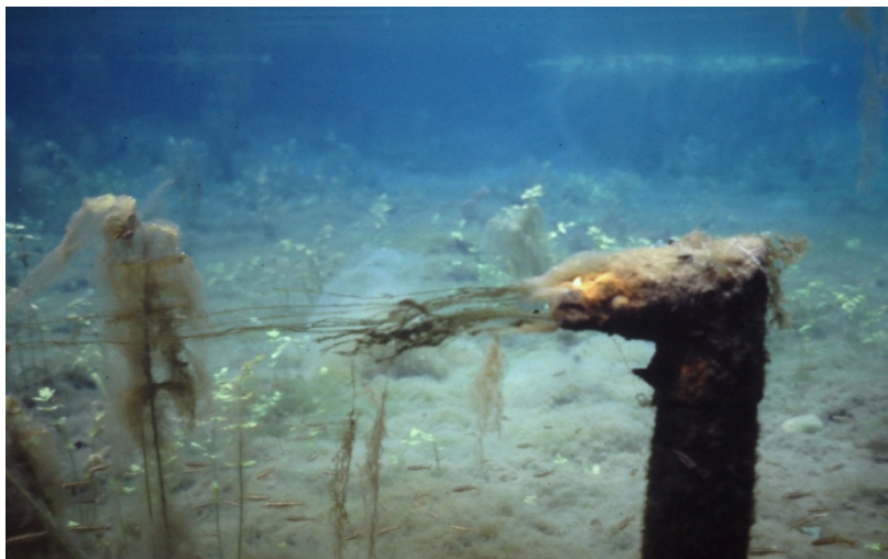
Bocca di presa acqua di risorgiva nel Fontanile Nuovo
