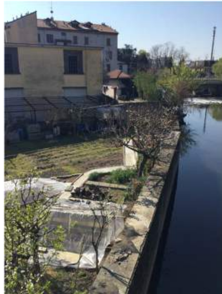
Sponda inaccessibile per fascia spondale In area privata
