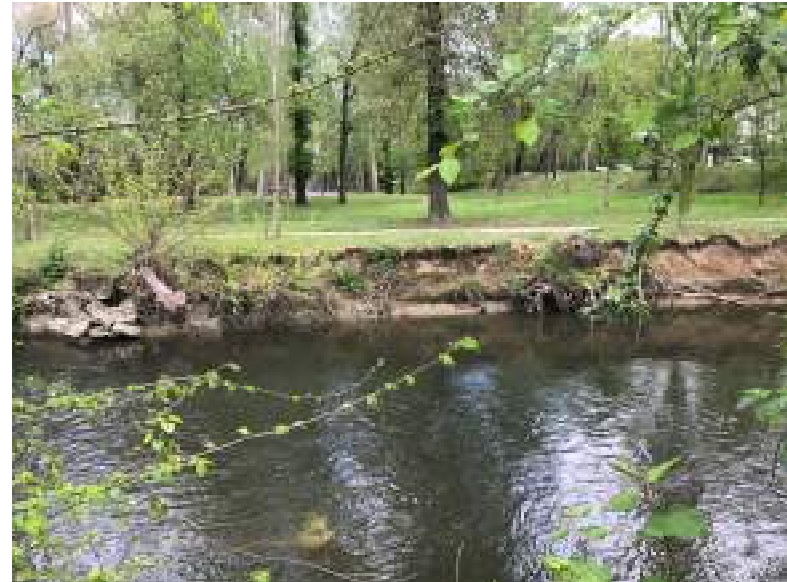
Erosione delle sponde
