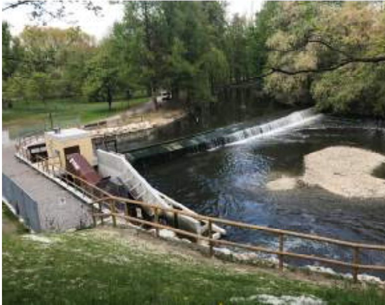
Sistemazione sponde e alveo per inserimento di una centralina idroelettrica
