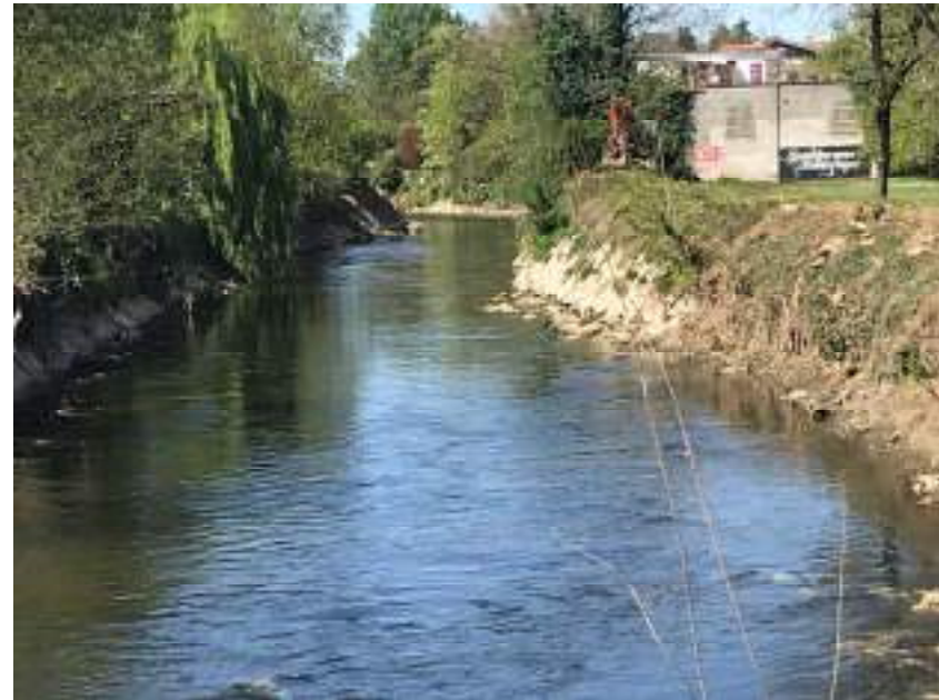
Sistemazioni spondali in massi ciclopici
