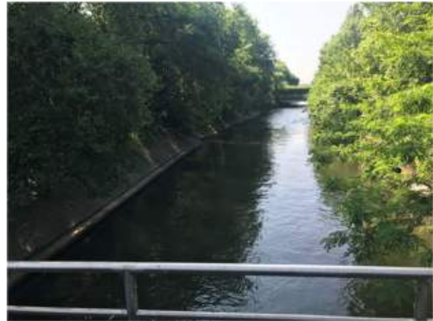
Sponde in cemento armato e ponti a raso
