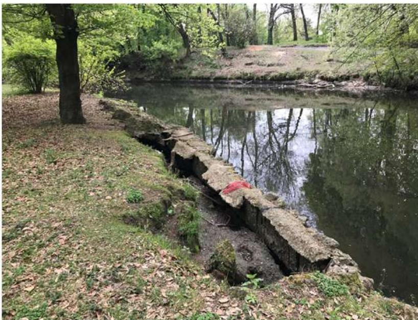
*Erosione delle sponde e scalzamento muro spondale*
